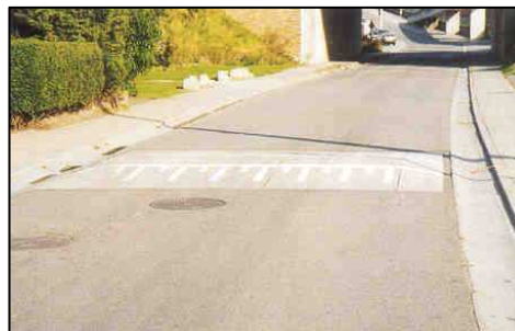
Profil surbaissé pour cyclistes Sources: Code de bonne pratique des aménagements cyclables, MET, Pro Vélo, sept. 2000
